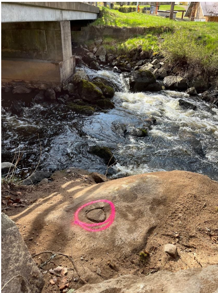
Figur 8. Fixpunkten i form av ett ringformat märke nedströms vägbron.
