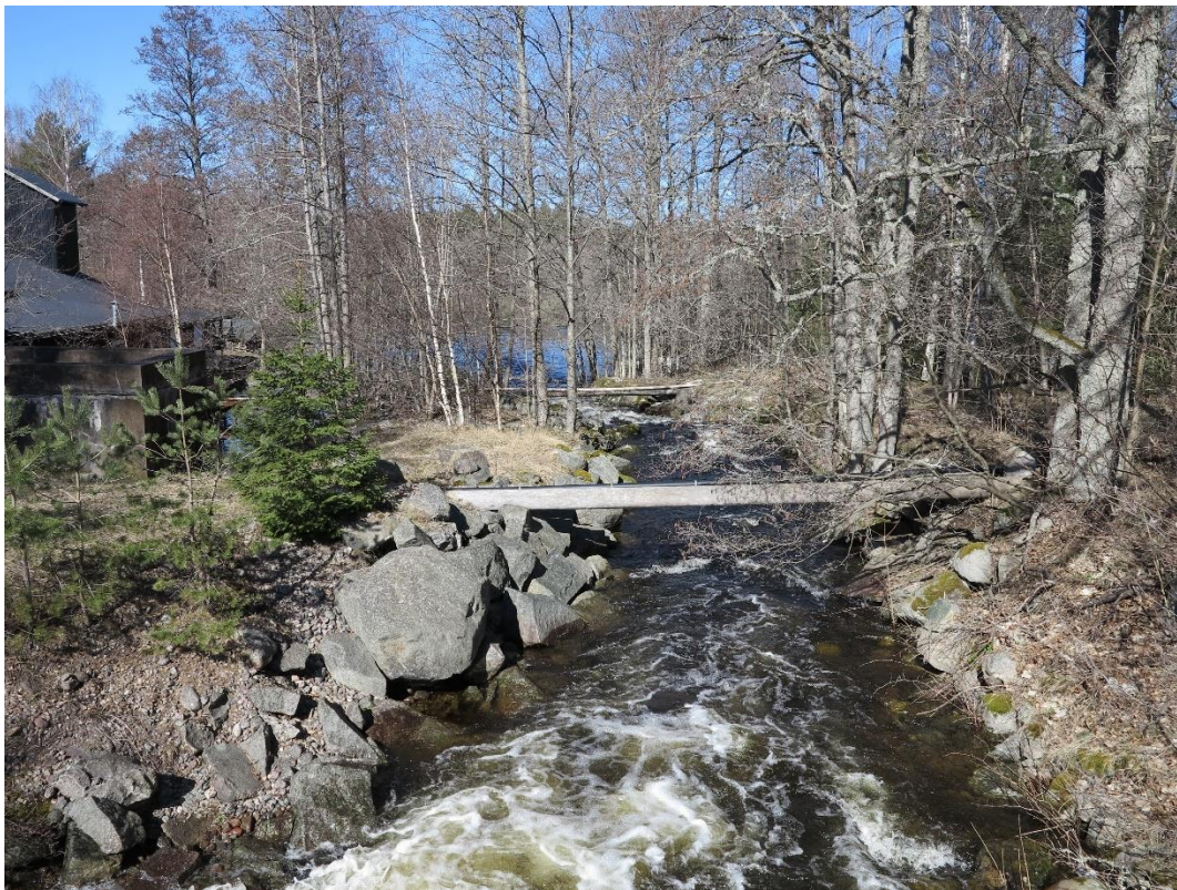
Figur 9. Strömsträckan på ca 40 meter nedströms dammen
