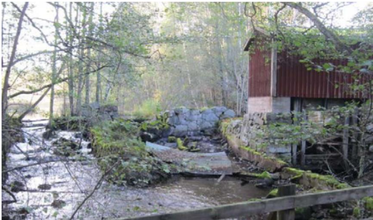
Figur 15. Kvarntorpet med sin delvis raserade dammvall. Källa: Länsstyrelsens i Jönköpings läns meddelade 2016:10 Minnen vid vatten.
